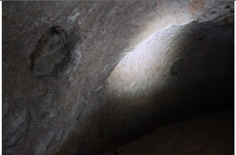
Nichos para colocação de iluminação
