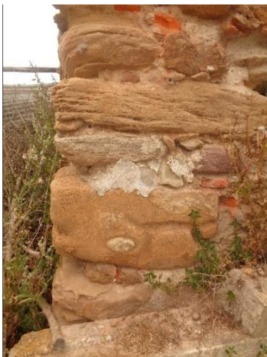
Pormenor da fachada
