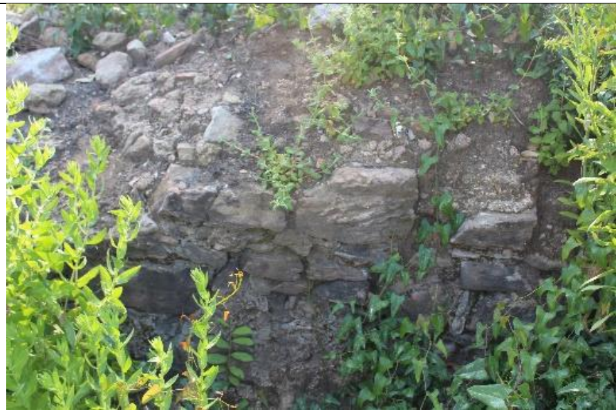
Vestígios da estrutura da Capela de São Pedro
