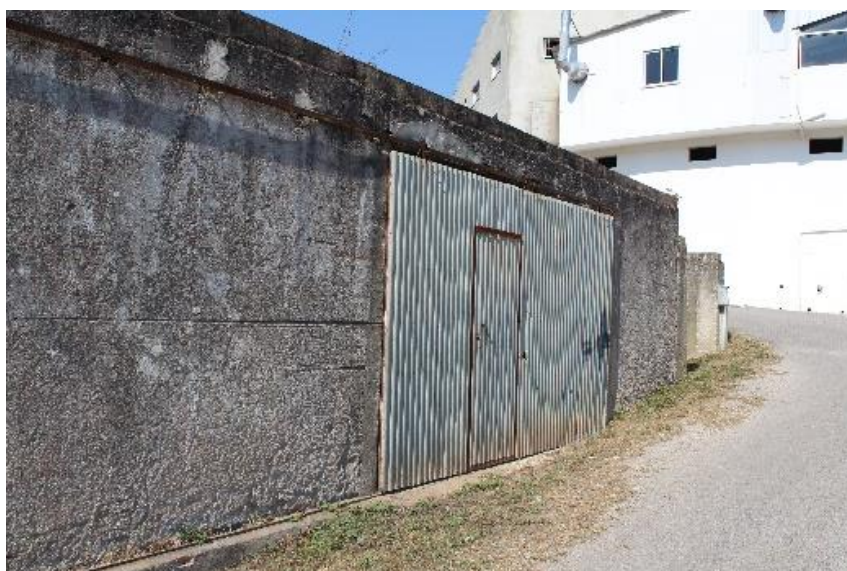
Garagem onde se localizará a entrada do túnel
