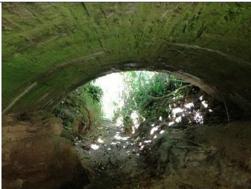
Ponte do Rio das Bruxas
