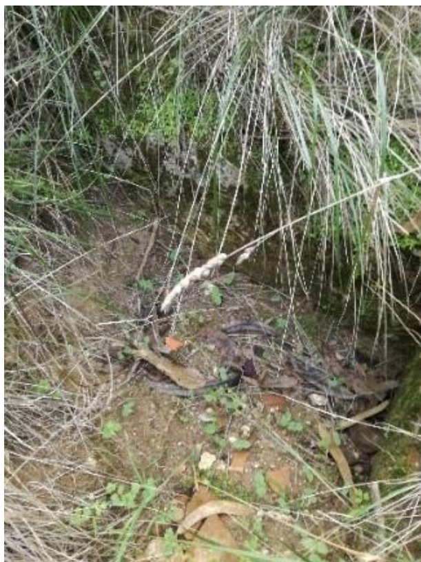
Vestígios da estrutura da Capela
