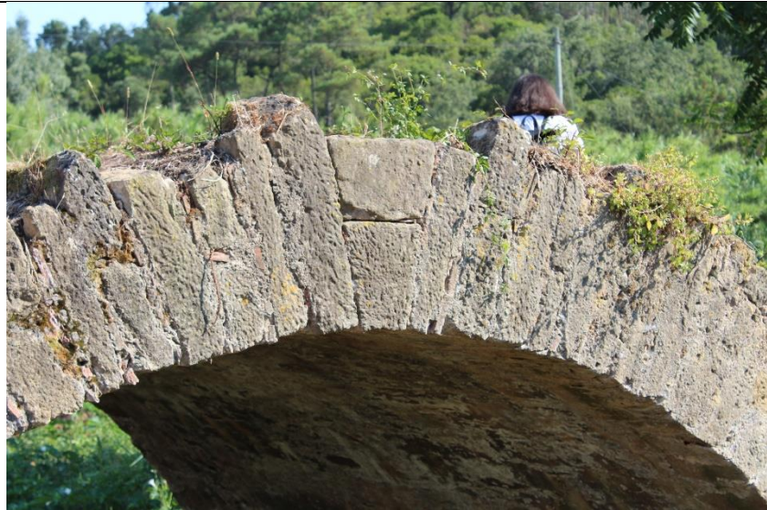
Pormenor da estrutura da ponte
